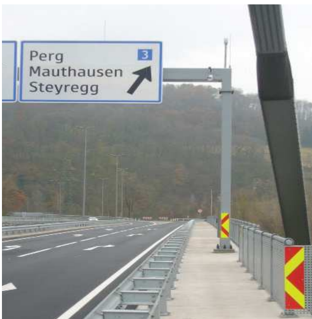
Engstellen auf der Brücke
