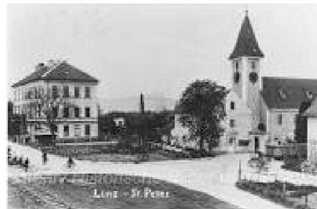
St. Peter bei Linz - Schulgebäude und Kirche
